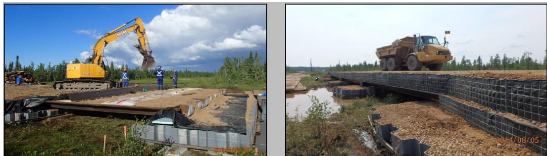
Joonis 18. Plokkidel ehitatud tee märgalal. Foto: Landmark Solutions Ltd 36 .
