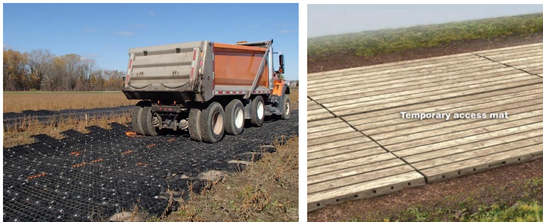
Joonis 15. Ehitusaegsete pinnasetugevdusmattide näidised. Vasakul GeoSystems kummimatid ja paremal puidust paneelid 35 .
